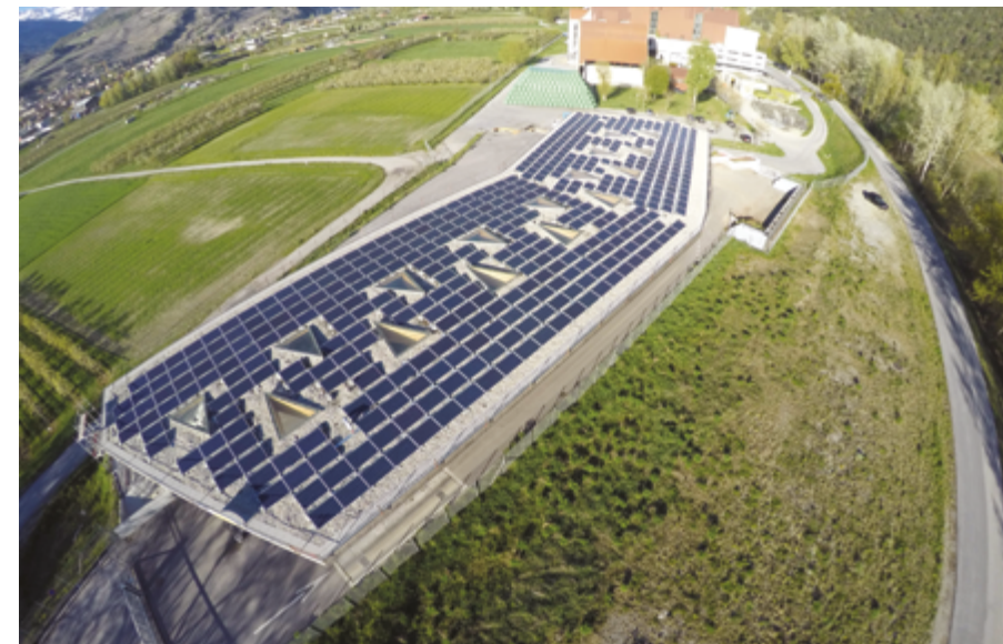
Vue aérienne de la déchetterie de l'UTO.
