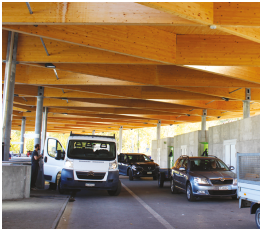
Aires de déchargement des déchets.
