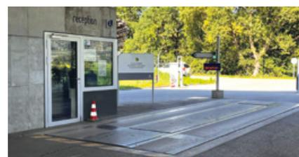
Un système de pesée à l'entrée et à la sortie résout le problème de l'estimation du volume déposé. Dès lors, la déchetterie peut établir une facture en fonction du type de déchets et de sa masse.
