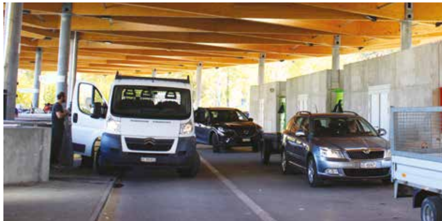
Aires de déchargement des déchets.
